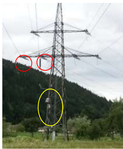
Slika 2. Steber SM 23 z dvema OTLM napravama (rdeče) in vremensko postajo, ki je obkrožena rumeno
